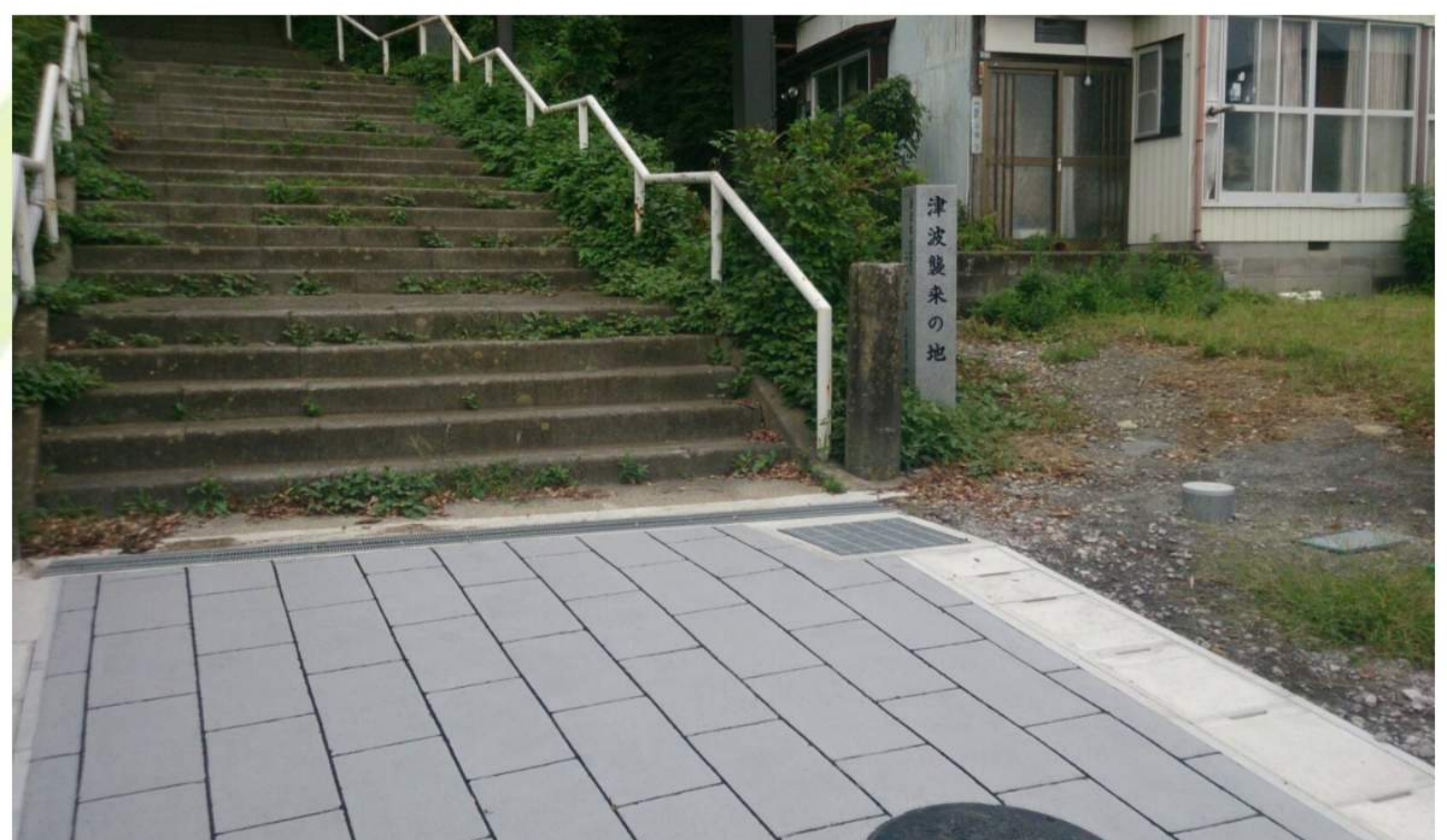
施工現場：石巻市新門脇（宮城県） 施工：ストリートプリント
