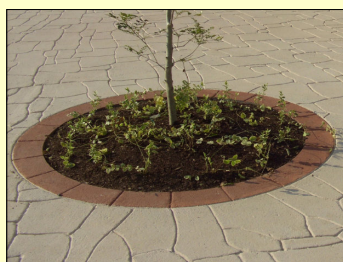
↑ボーダーテンプレートを用いて レンガ調のツリーサークルが完成！
