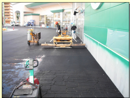
↑【SR60】でアスファルト加熱中
