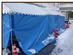
▲テントを張って、 その中での作業です!
