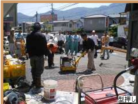
アスファルトを熱した後に、型を押し込んでいる所です。
