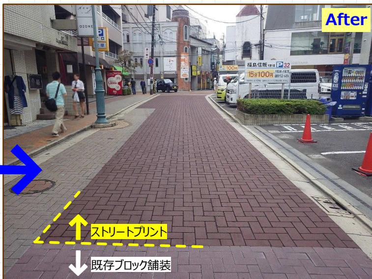
▲手前の既存ブロック舗装に合わせてヘリンボーンにて施工
