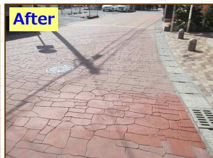
こちらの写真のように、水道配管工事跡等で「一部だけアスファルト舗装になっている」というのを街中で目にされる機会も多いかと思えます。ストリートプリントは、**既存のアスファルト舗装に直接【型押し・着色】**をするので、このような場合でも、**簡単に部分補修が可能**です。また、**施工時と同じパターン・カラー**にて施工いたしますので、何事もなかったかのようにピシャッと元通りです!!
