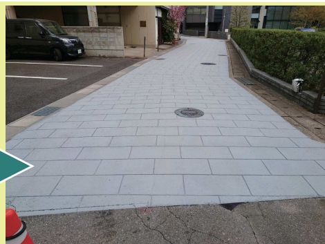
ストリートプリント 施工後
