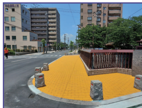
【山口県 周南市 橋補修工事】
