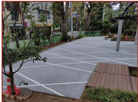
府中市のUR都市機構様に、ストリートコートを224m<sup>2</sup>ご採用いただきました。開粒アスファルト表面にストリートボンドを用いて着色を行い、さらに玉吹き仕上げを施すことで、洗い出し風の意匠性を持たせた舗装としました。
