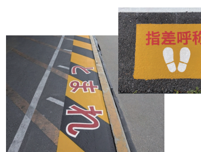
▲物流倉庫 構内
